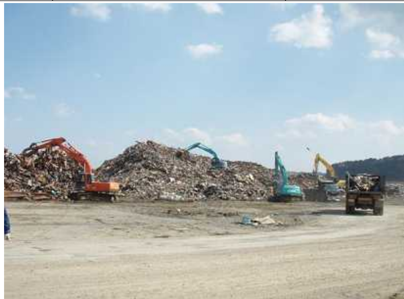
活動状況(がれき・災害廃棄物仮集積場の様子)
